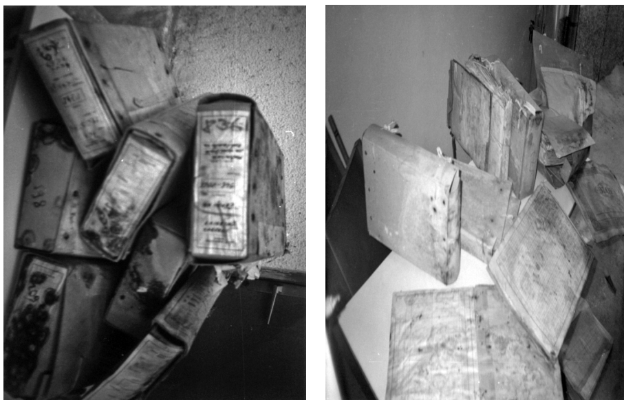
Slika br. 3. Arhivska građa u depoima oštećena vlagom 19
